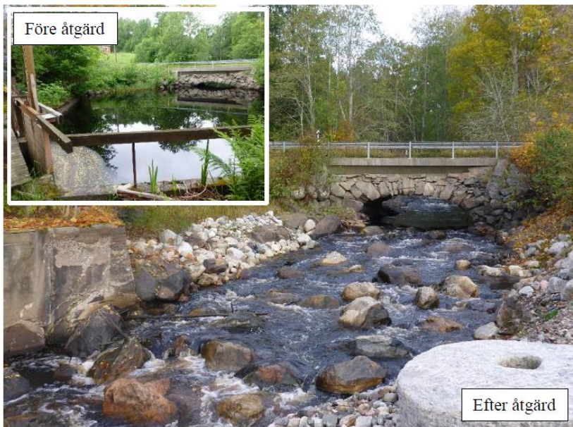
Figur 1. Vattenvårdsåtgärd där vattenspegeln helt tagits bort och forsen är återskapad (Gullspångsälvens vattensystem).
