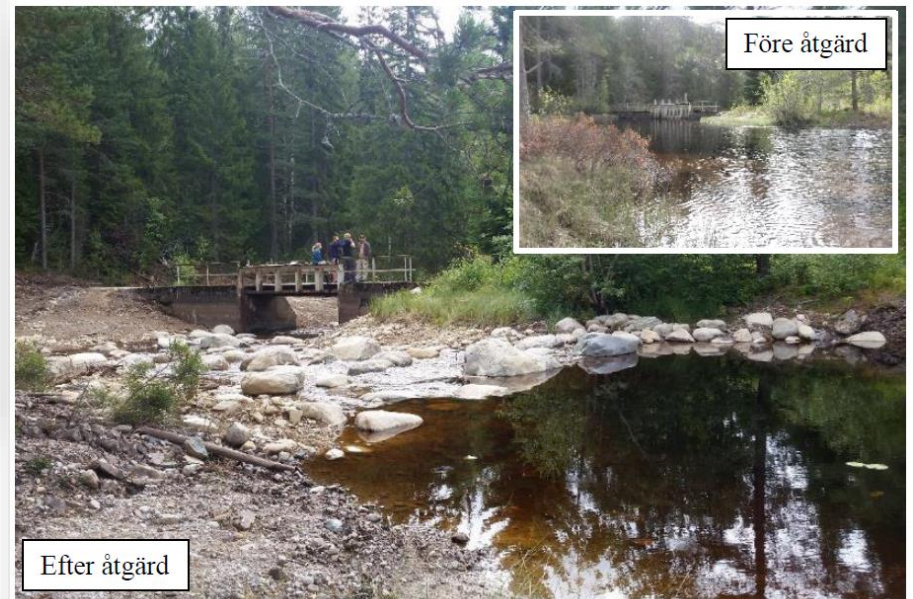
Figur 2. Vattenvårdsåtgärd där en sjötröskel byggts vid en naturlig sjö (Arbogaåns vattensystem).
